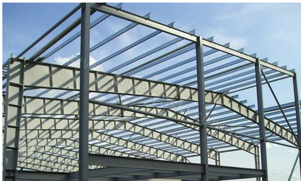
Рисунок 2.1 - Z-образный стальной тонкостенный холодногнутый профиль в качестве прогонов
