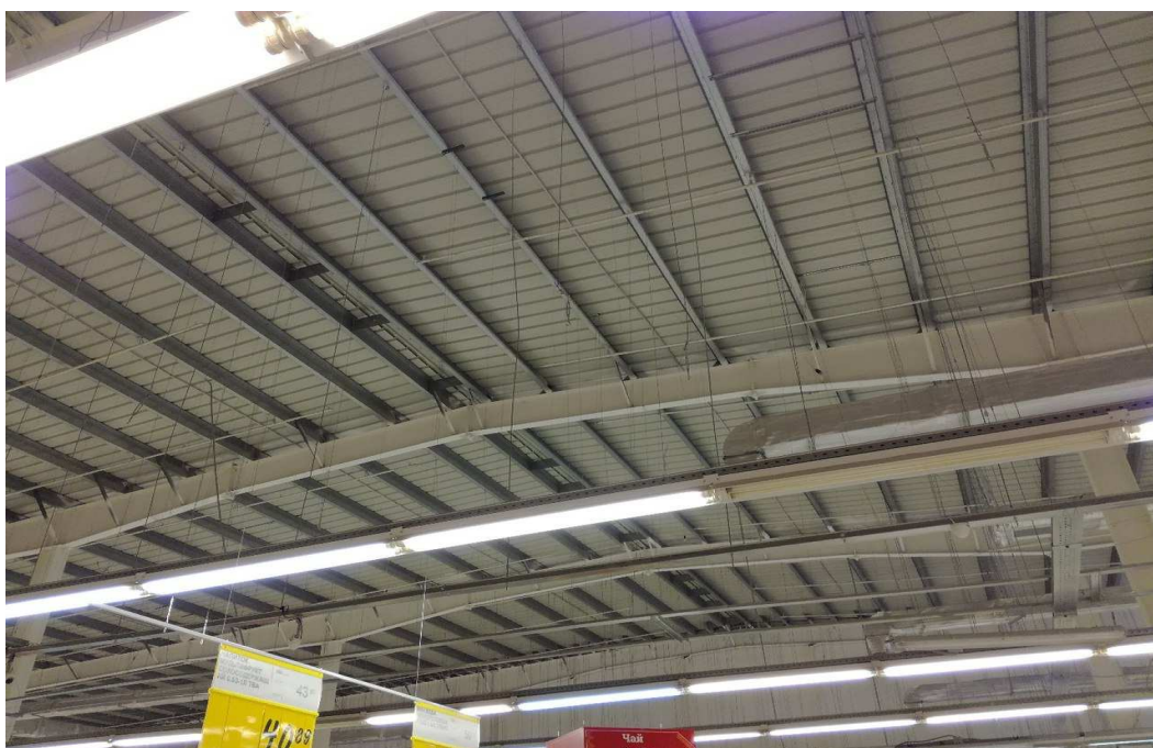
Рисунок 2.1 - Z-образный стальной тонкостенный холодногнутый профиль в качестве прогонов
